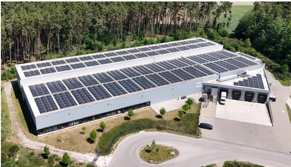
Una de las cuatro naves de producción en las instalaciones de Saal Digital en Röttenbach (Alemania) © Saal Digital
